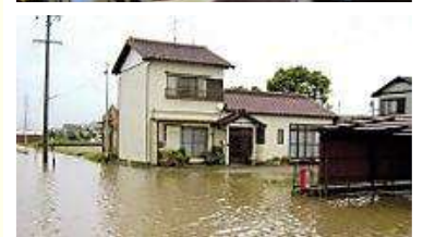
建設地の水田と隣接する住宅の浸水被害 (2004 年 7 月)
